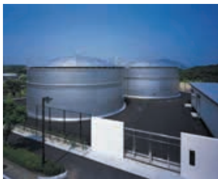
第2低区配水場(坂戸)
