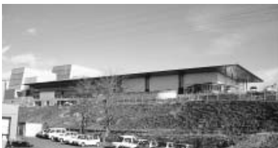
完成間近な文化創造センター
