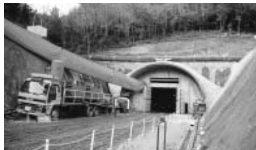
建設が進む大平トンネル
