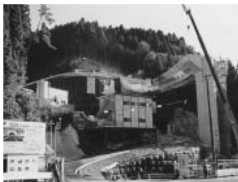
久々利小萱地区の建設現場
