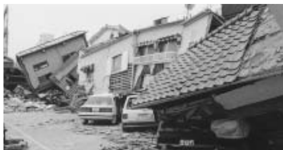
倒壊した家屋（阪神・淡路大震災）
