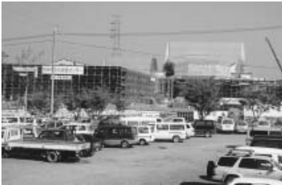
建設が進む文化創造センター
