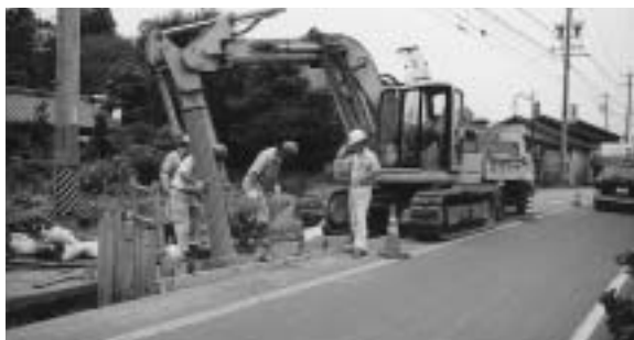
市内で行われている下水道工事
