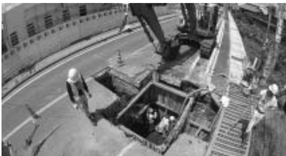
市内で行われている下水道工事
