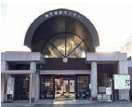
一次避難所でもある帷子地区センター
