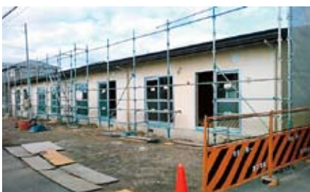
長寿命化計画に基づき改修中の市営東野住宅
