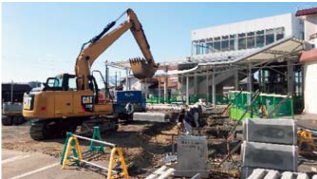
整備が進む可児駅前広場
