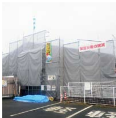
工事が進むめぐみ保育園
