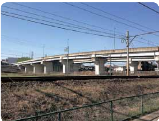
国道248号線アール・住吉南交差点高架橋
