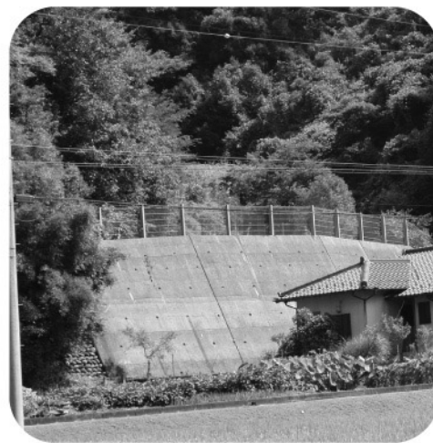
急傾斜地崩壊対策事業による工事(古瀬)
