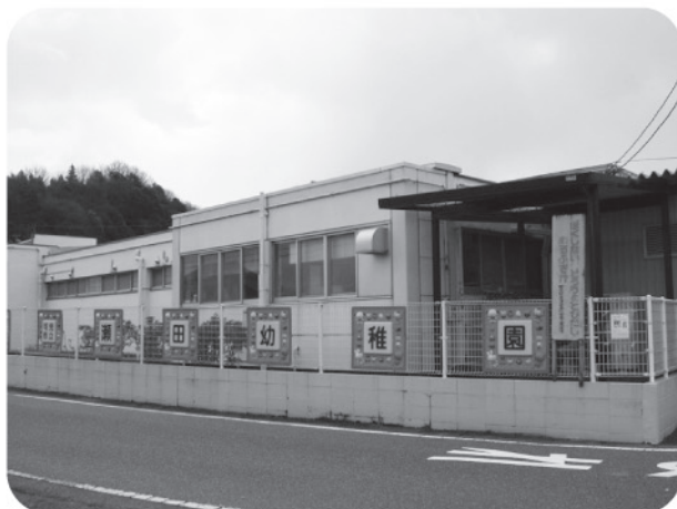
耐震補強工事で安全確保を(瀬田幼稚園)
