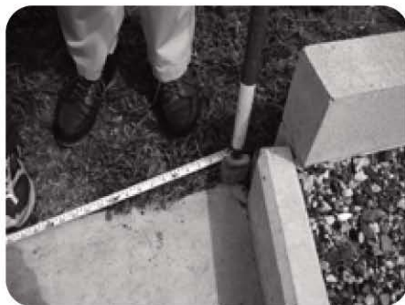
境界確認の作業現場
