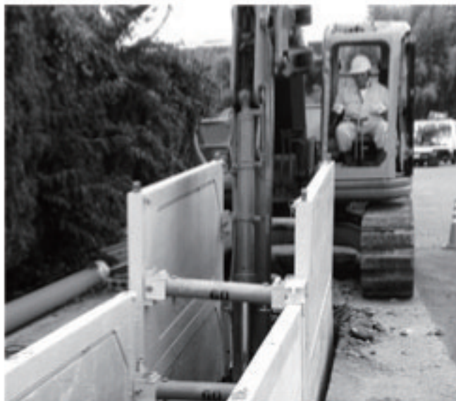
下水道管渠布設工事の様子
