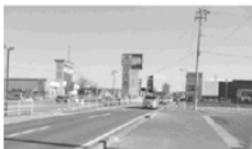
県道御嵩・犬山線 坂戸付近
