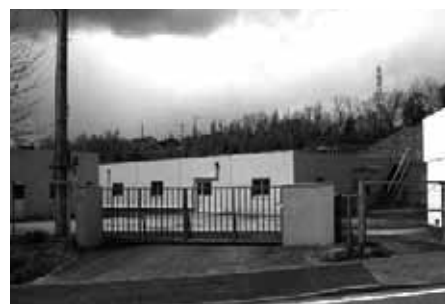
集中浄化槽（羽生ヶ丘）
