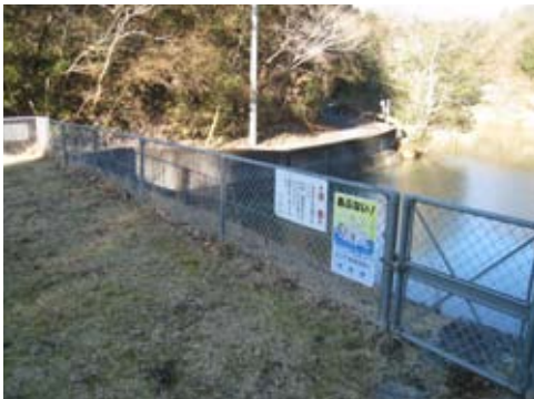
上池ため池（久々利）の安全対策の状況
