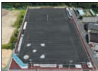
整備中の可児市運動公園グラウンド
