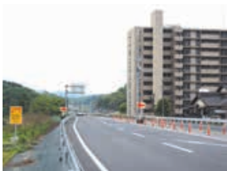
国道248号線4車線化の状況 (徳野南交差点付近)
