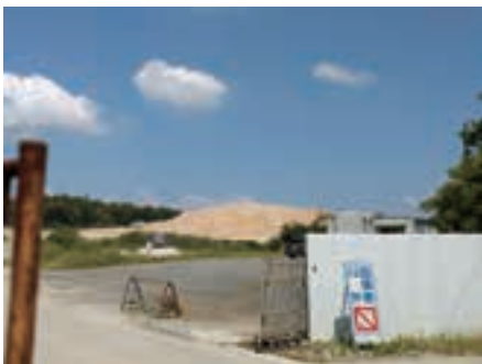
大森工区内で発生した建設残土
