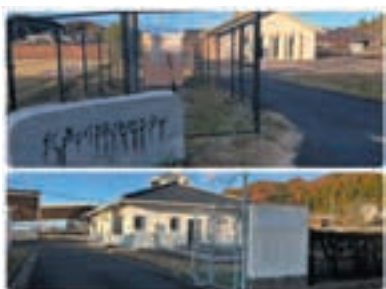
矢戸川浄化センターと横市川浄化 センター
