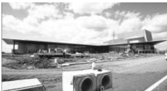
完成間近な文化創造センター
