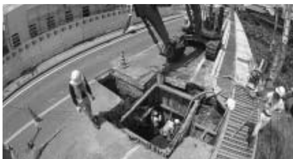
市内で行われている下水道工事
