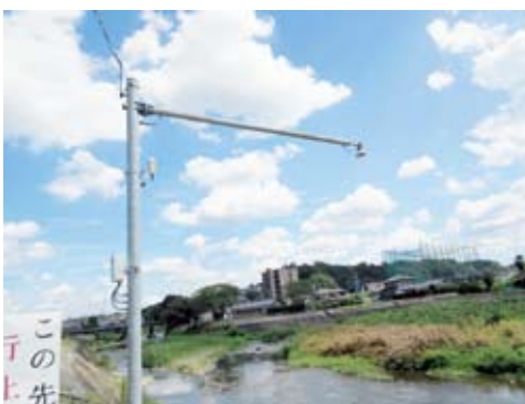
可児川に設置された水位計
