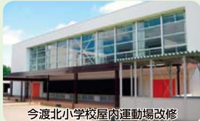
今渡北小学校屋内運動場改修
