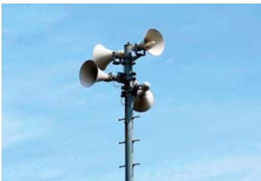
市内186カ所に設置してある防災行政無線
