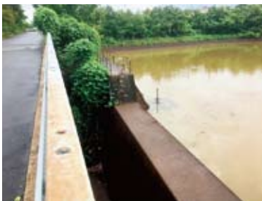
香ヶ洞ため池の堰堤
