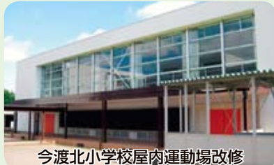
今渡北小学校屋内運動場改修
