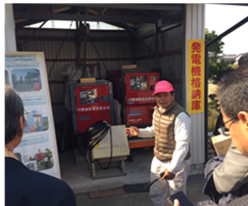
発電機格納庫
