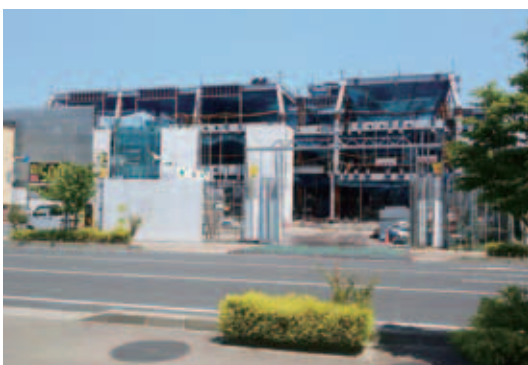
駅前子育て拠点施設工事風景
