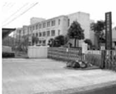
大規模改修される今渡北小学校
