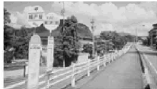
第二期工事まで完了の現・兼山バイパス
