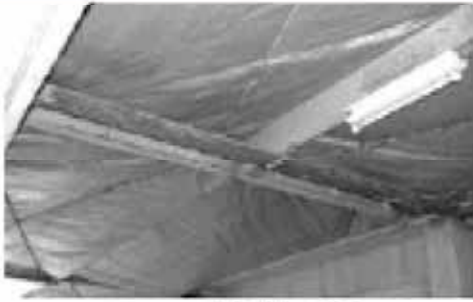
アスベスト調査中の施設
