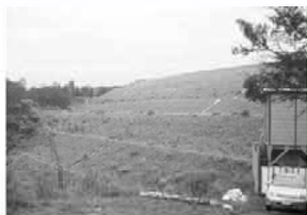
建設残土処分場と水処理プラント
