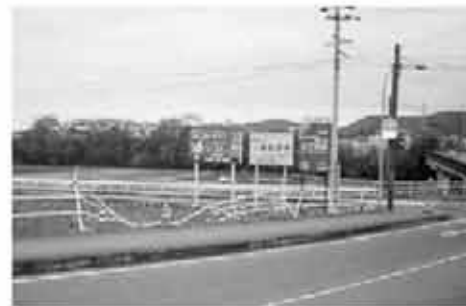
破損されたままのガードレール
